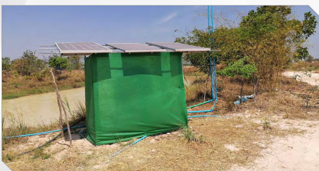
การติดตั้งระบบพลังงานทดแทนจากพลังงานแสงอาทิตย์ และระบบสูบน้ำบาดาล
