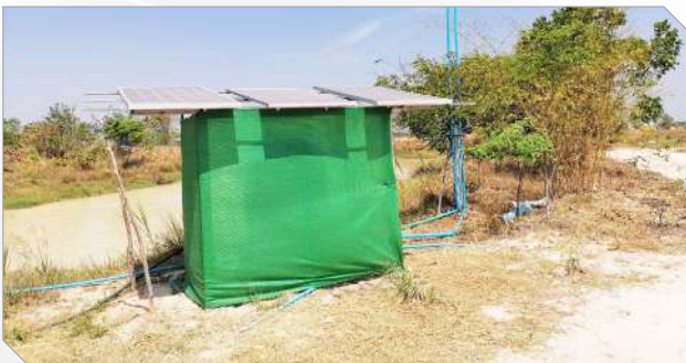
การติดตั้งระบบพลังงานทดแทนจากพลังงานแสงอาทิตย์ และระบบสูบน้ำบาดาล
