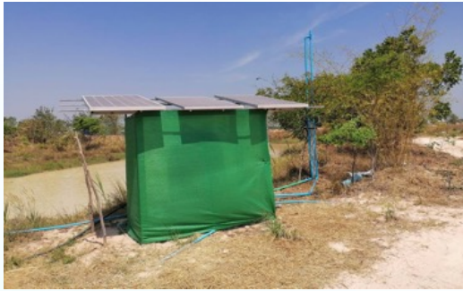
การติดตั้งระบบพลังงานทดแทนจากพลังงานแสงอาทิตย์ และระบบสูบน้ำบาดาล
