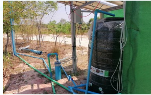
การติดตั้งระบบพลังงานทดแทนจากพลังงานแสงอาทิตย์ และระบบสูบน้ำบาดาล
