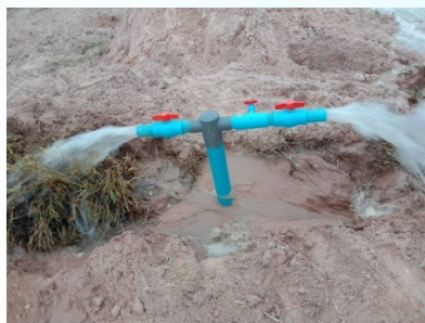
การขุดร่องสร้างชลประทานระบบท่อสำหรับส่งน้ำเข้าพื้นที่ทางการเกษตร
